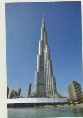
全球最高建築物哈里發塔，基底寬闊，重心低矮
