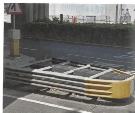
(ii) 如果汽車撞上風琴式防撞欄，防撞欄會變形，延長撞擊時間
