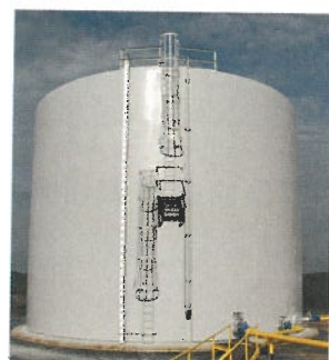
圖 4.3g 燃料儲存缸是銀白色的，能反射來自太陽的能量，以免儲存缸過熱
