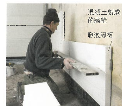
圖 4.1j 在混凝土牆壁上鋪上發泡膠夾層
