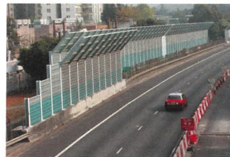
(i) 在公路旁興建隔音屏障來將噪音反射和吸收
