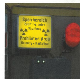
(ii) 儲存放射性物質的地方須加上警告標誌
